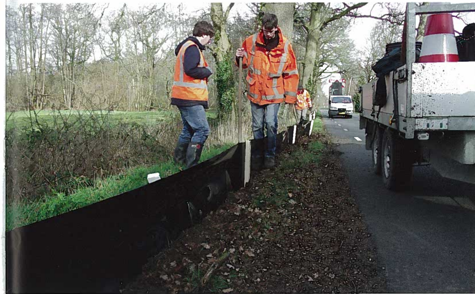
Aanleg van tijdelijke paddenschermen tussen Laag Soeren en Dieren. De padden worden bij het scherm in de ochtend en avond opgevangen en de weg overgezet. In het Siddebuursterbos in Slochteren staat een oeverzwaluwwand annex vleermuiskelder. Het onderhoud aan de wand - aanvullen van het zand in de pijpen waarin de zwaluwen nestelen - gebeurt door de gemeente en vrijwilligers.
